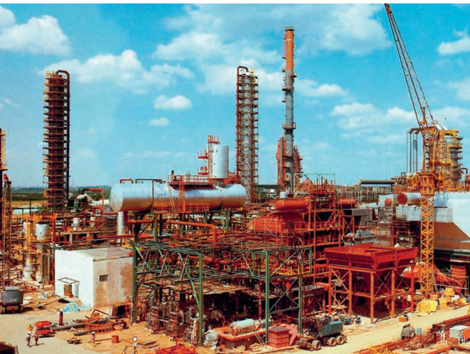
Arbeiten der KWE bei der petrochemischen Industrie
